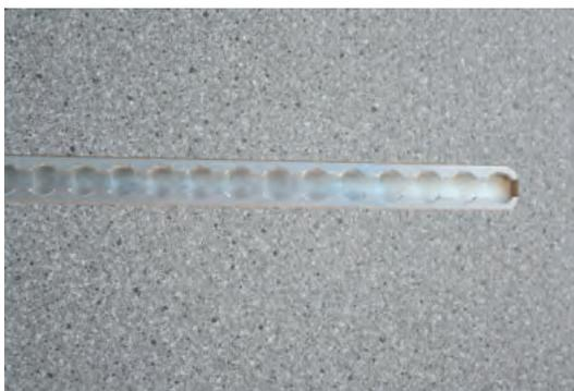
Abbildung einer in die Bodenplatte hinein gefrästen Zurrschiene
